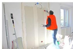
Consente la lisciatura di rivestimenti, cordoli, intonaci. Facile da usare grazie alla sua struttura leggera ed ergonomica. Adattabile a pali telescopici in EDMA (manico e pali non forniti). Lama in acciaio inox con bordi arrotondati per un risultato senza tracce o perdite di rivestito. Spessore lama: 0,3 mm.
