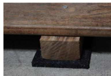
Per isolare il travetto da terra. Protegge dall'umidità. Riduce il trasferimento del rumore al passaggio. Stabile e resistente. Deve essere utilizzato su pavimento compatto e livellato.
