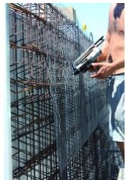
Pressione di esercizio 5-8 bar. Capacità caricatore: circa 100 CL 24 punti. Applicazioni:- Cassaforma per piscine.- Fissaggio industriale.
