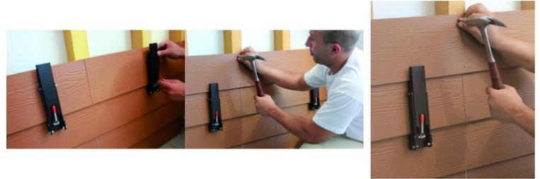
Set di 2 pezzi. Consente la posa di rivestimenti sovrapposti (fibrocemento, fibra di legno o tipo legno) da parte di 1 sola persona. Tenere le tavole in posizione prima della chiodatura con sovrapposizione di 30 mm. Per tutti i rivestimenti da 6 mm a 16 mm di spessore. Regolabile per diverse larghezze di rivestimento da 160 mm a 255 mm. Esempi di larghezze di rivestimento: - 180 mm tipo Hardie Plank. - 190 mm tipo Cedral. - 210 mm tipo Duracolor o Hardie Linea. - 225 mm tipo Ced'R-Tex.
