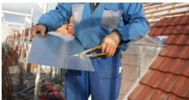
Acciaio al carbonio. Capacità di taglio:- 1 mm: acciaio inossidabile.- 1,5 mm: lamiera zincata, zinco. Per tagli lunghi dritti e curve lunghe. Lunghezza lama: 30 mm. Lame da 56 HRC a lunga durata. Manici con rivestimento in PVC (isolamento termico) .
